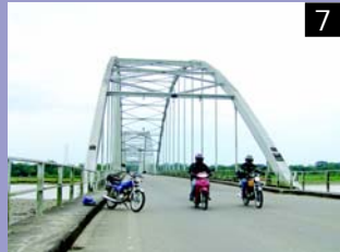
Puente El Alcaraván: Se construyó para reemplazar al puente Guillermo León Valencia que fue arrasado por el río Ariari, comunica a Granada con la Serranía de la Macarena.
